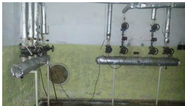
Rozdělovač a sběrač v kotelně
