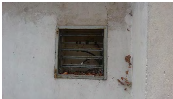
Odpojený hlavní rozvaděč
